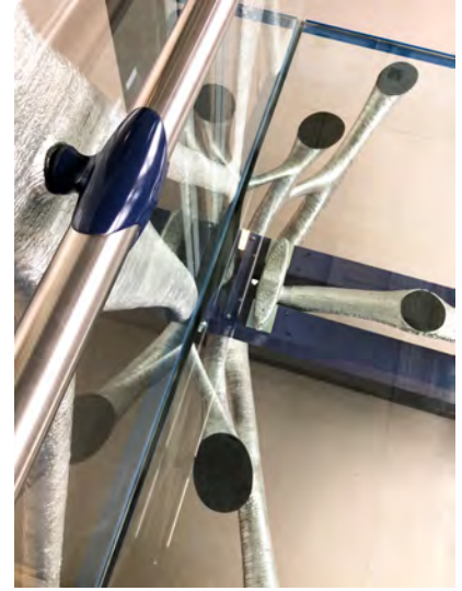
Tırabzan montajını, yan ve zemin yapısını gösteren içeriden bir görüntü; Schindler'in izni ile
