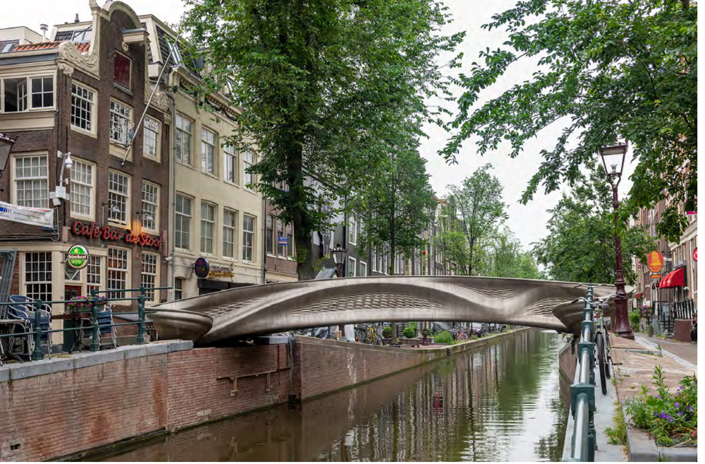
Amsterdam, Hollanda, çelik köprü, MX3D tarafından "baskı" yöntemiyle yapıldı; MX3D'nin izni ile Steel bridge in the city center of Amsterdam, The Netherlands, "printed" by MX3D; courtesy of MX3D
